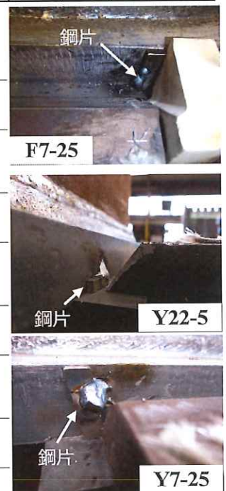
写真 1 鋼片の取付け状況
