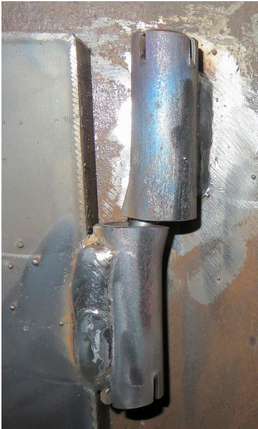
資料写真 5 載荷後-上側(下向溶接-A 試験体)
